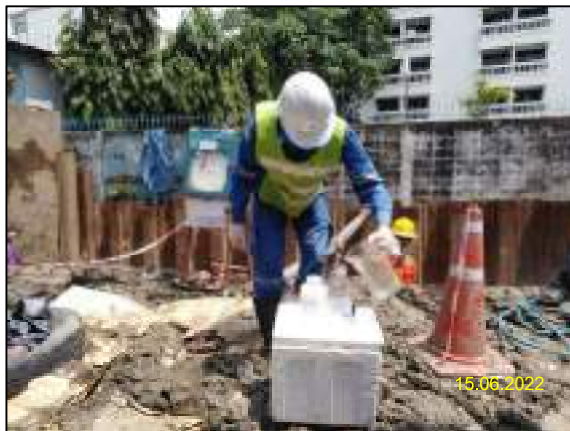
รูปที่ 3-10 การติดตามตรวจสอบคุณภาพน้ำทิ้งจากการทดสอบท่อด้วยวิธีทางชลสถิติ
